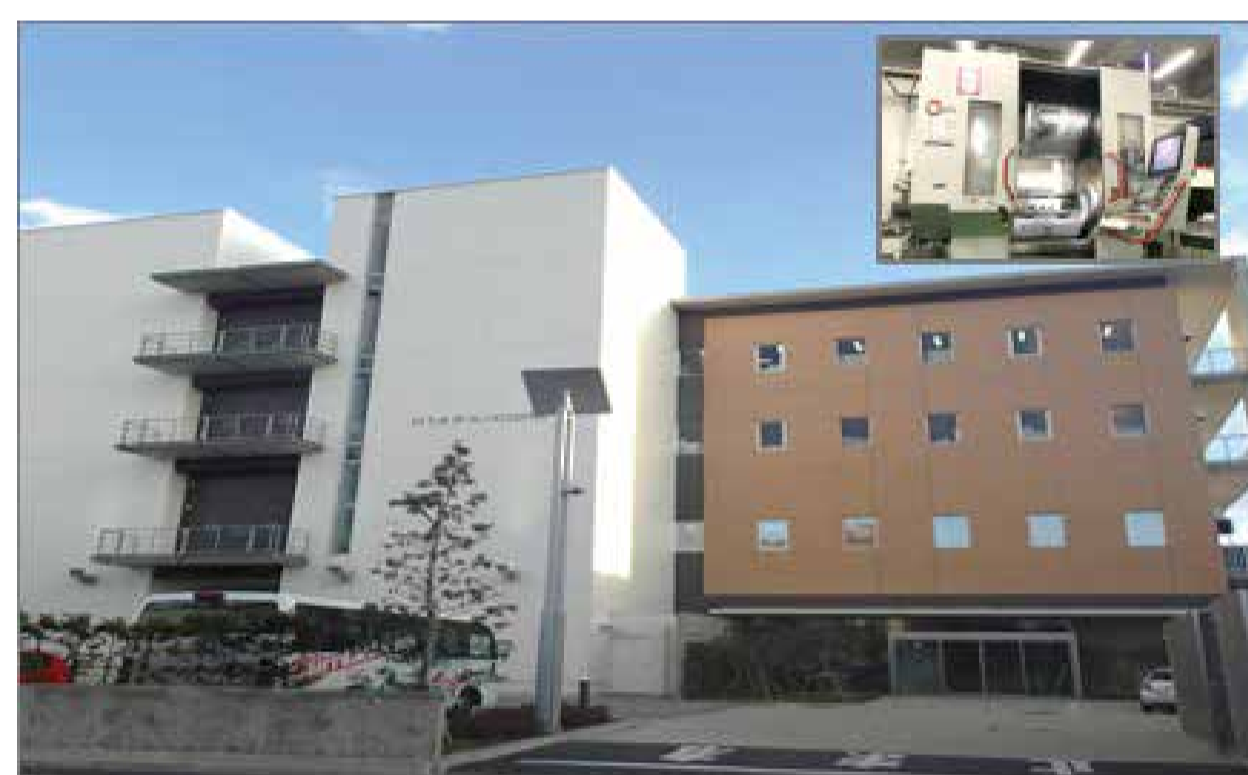
試作 東京テクニカルセンター
